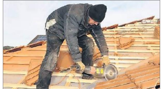
Mit der Diamanttrennscheibe Ziegel zerschneiden
