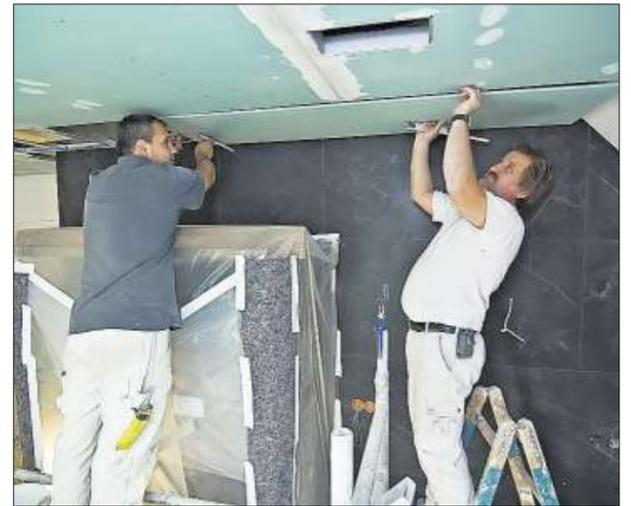
Stuckateure montieren beispielsweise Gipskartonplatten, nachdem sie sie ausgemessen haben und später verputzen. Foto: berufenet
