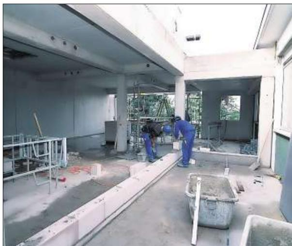
Im Rohbau wird eine Zwischenwand gemauert.
