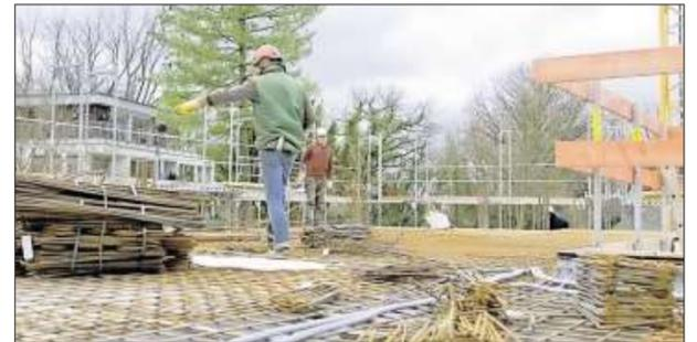
Hier wird auf einer Rohbau-Geschossdecke Bewehrungsstahl verlegt.
