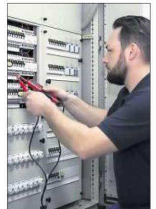
In einem Verteilerkasten wird die Spannungen gemessen.
