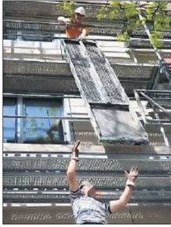
Gerüstbauer arbeiten an einer Hausfassade. Gerüste werden regelmäßig an nahezu jedem Bauwerk benötigt. Foto: berufenet
