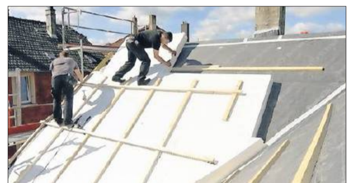
Dachdecker bringen eine Isolierung auf dem Dach an. Foto: berufenet
