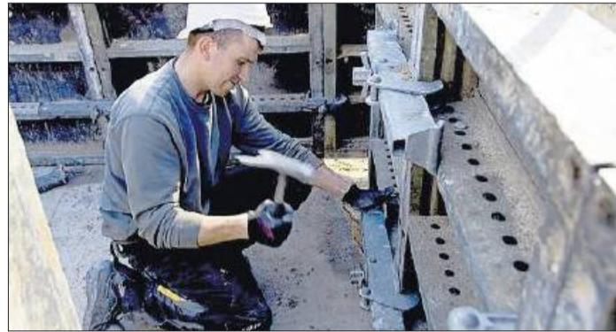
Der Beton wird in vorbereitete Schalungen gegossen. Foto: berufenet
