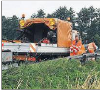
Straßenwärter sichern eine Baustelle ab. Foto: berufenet
