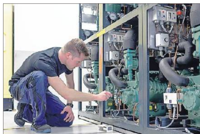
An einer Kältepumpe wird ein defektes Steuergerät ausgetauscht.
