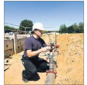
Vom einzelnen Rohrstück zum gesamten Leitungssystem: Für den sicheren Anschluss sorgen Rohrleitungsbauer. Foto: berufenet
