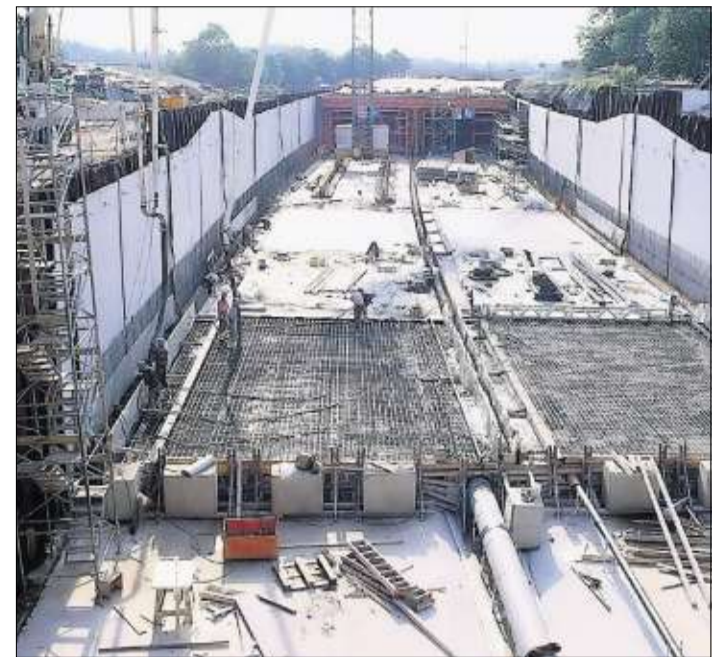
Ein normaler Arbeitsplatz für Spezialtiefbauer
