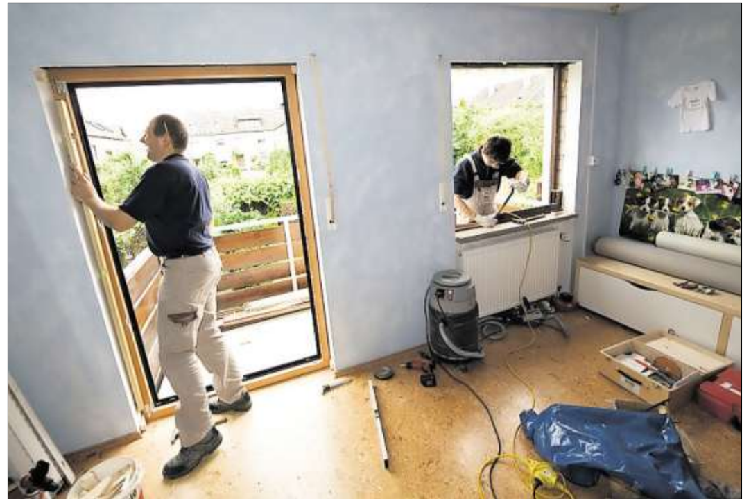
Fenster beim Kunden austauschen
