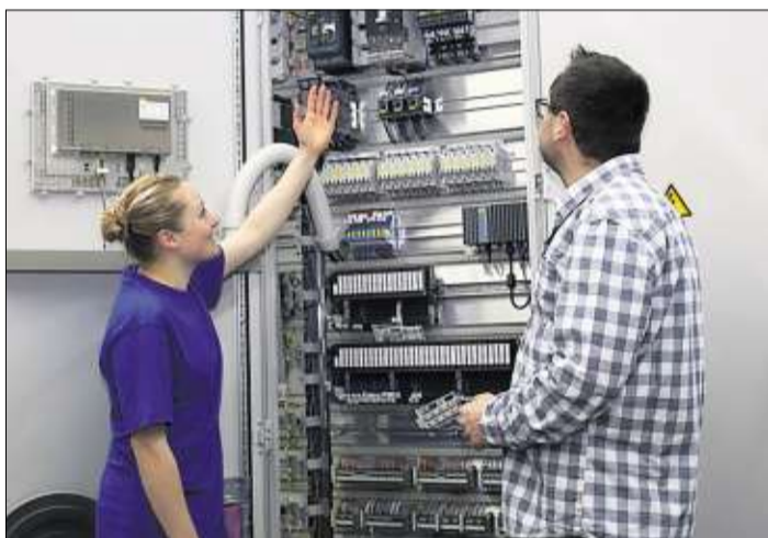
Die Einweisung der Kunden gehört zum Berufsbild. Hier wird eine Steuerungsanlage erklärt. Foto: berufenet
