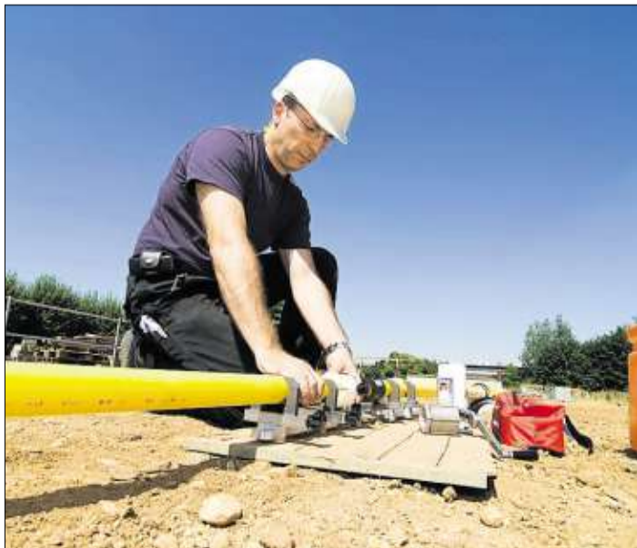
Eine Schweißverbindung wird vorbereitet. Foto: berufenet
