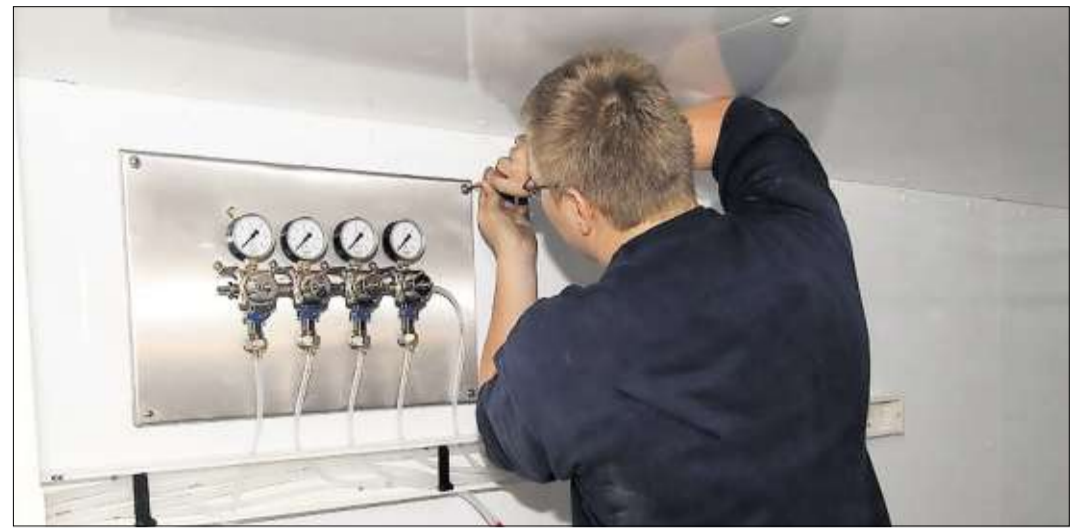
Ein Durchlaufkühler wird vor Ort eingebaut.
